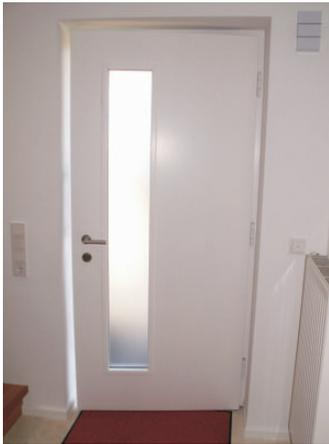
Eine moderne Haustür sollte mit mindestens drei Bändern angeschlagen sein. Entgegen „althergebrachter Gepflogenheiten“ gehört das dritte Band in die Türmitte. Hier hebt der Einbrecher - aber hier wird auch die größte Wirkung gegen einen bandseitigen Türblattverzug erzielt.
